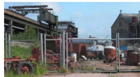
Brukets anläggningar förfaller
