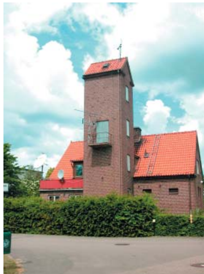
Kattarps före detta brandstation
