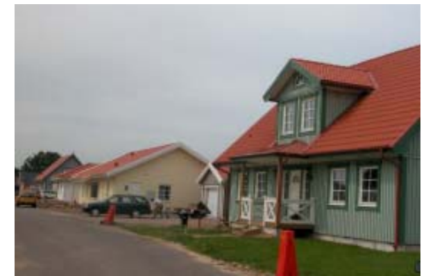
Ny bostadsbebyggelse i västra Pårarp.
