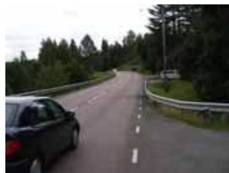
Vägsektionen är trång och utrymme saknas för gående och cyklister
