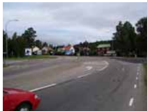
Korsningen vid OK sedd söderifrån
