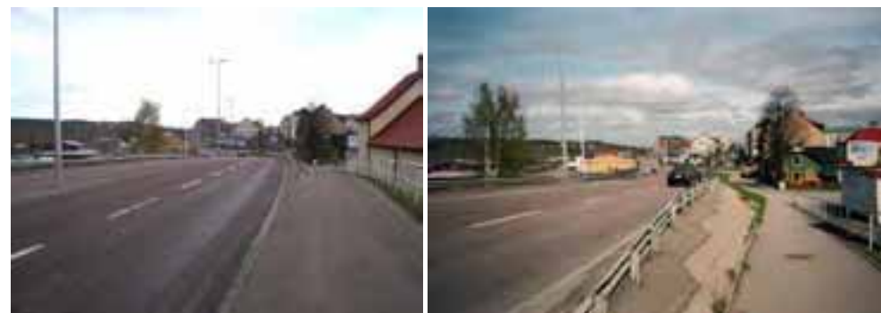
Stadsentrén sedd norrut från viadukten
