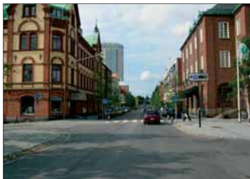
Storgatan efter ombyggnad
