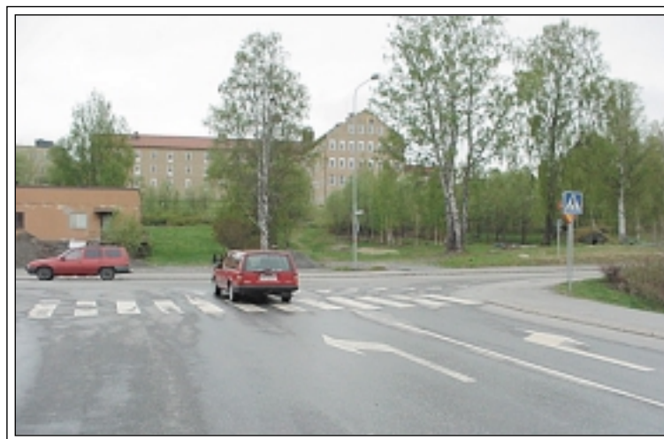
Exempel på gångpassage som inte har en acceptabel utformning ur trafiksäkerhetssynpunkt
