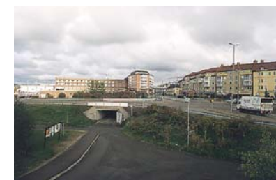
Passagen under Korsnäsavvägen ersätts med ett rakt stråk i Holmgatans förlängning när Korsnäsavvägen byggs om.
