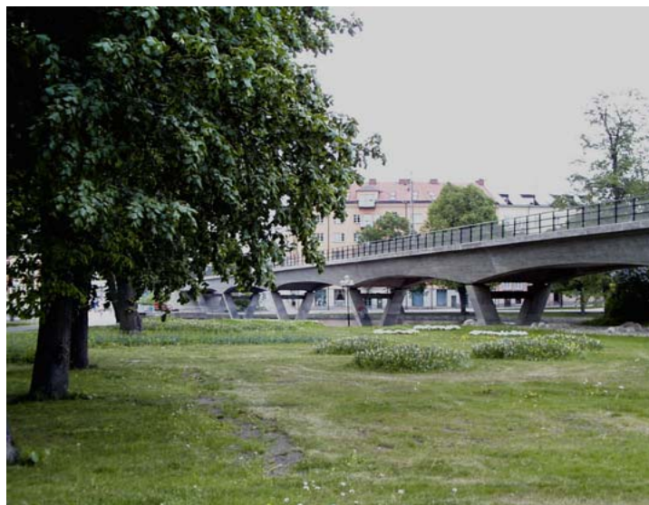
Nya öppningar i banvallen vid ån (Bild från Eskilstuna)
