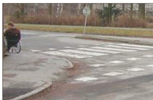
En avfasning som lutar 22 % är ett exempel på ett hinder som är enkelt att åtgärda.
