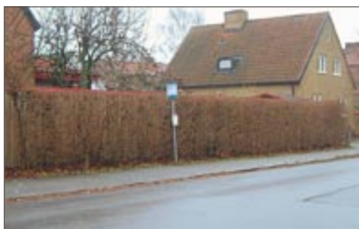
En hållplats utan hög plattform, taktil information och väderskydd kan inte användas av alla, ett exempel på ett svårt hinder. Ombyggnaden blir kostsam.
