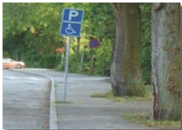
En stolpe mitt i gångbanan kan bli en obehaglig överraskning för den som ser dåligt. En ojämn gångyta är en snubbelrisk för alla
