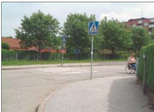
Före: övergångsställe med smala avfasningar med för stor lutning, ingen taktil information och dålig målning.
