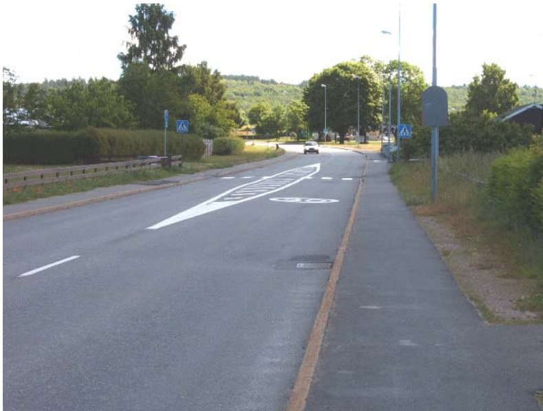
Figur 6.14 Korsningen Linnavångsvägen/gc-väg i Näsrum
