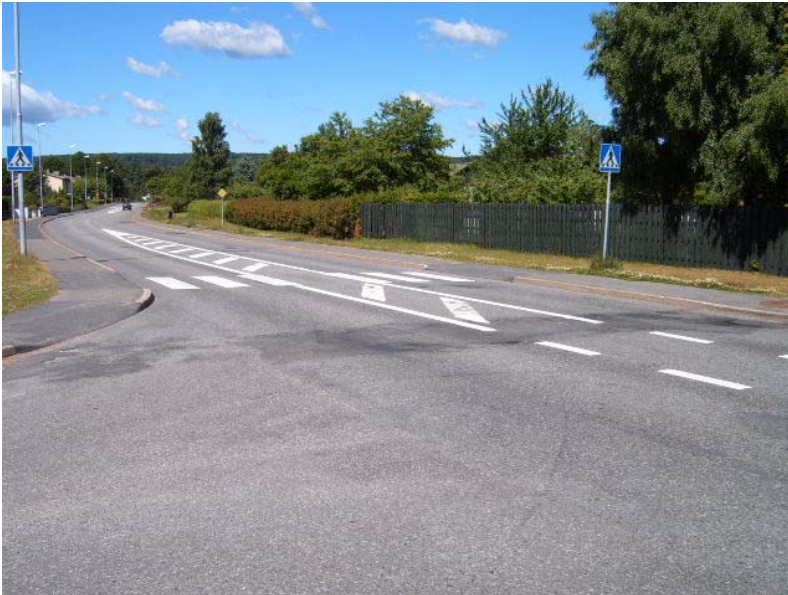
Figur 6.16 Övergångsställe på Linnavångsvägen i anslutning till korsningen med Kyrkvägen.
