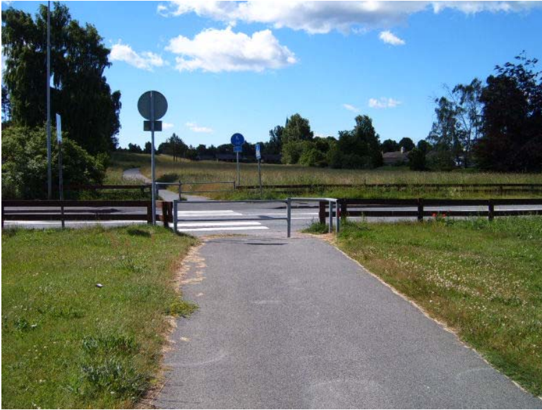
Figur 6.15 Ge-vägen över Linnavångsvägen
