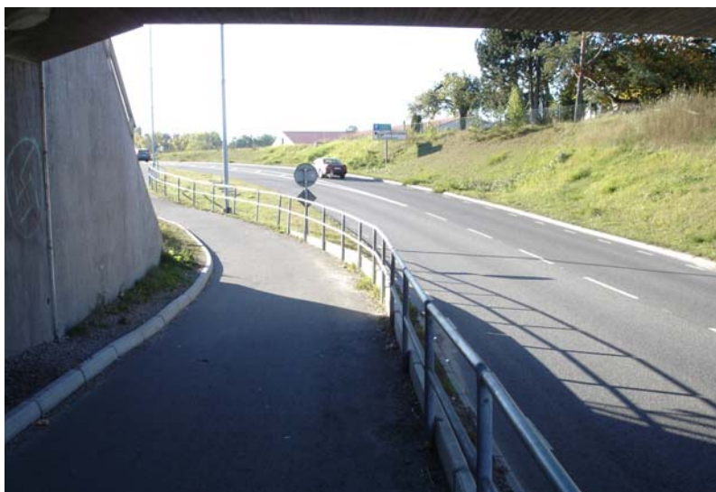
Figur 6.5 Gc-vägen under järnvägsviadukten, sikten söderut
