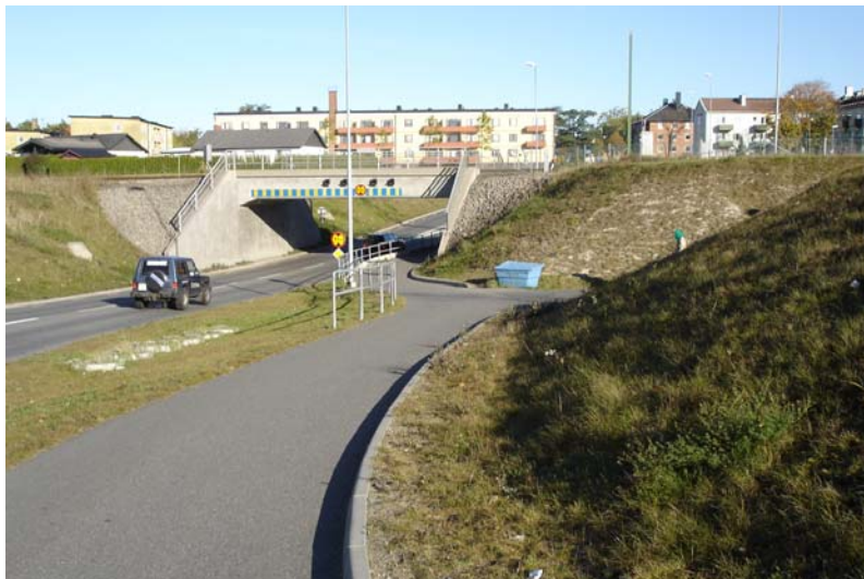
Figur 6.4 Gc-vägen under järnvägsviadukten, sikten norrut
