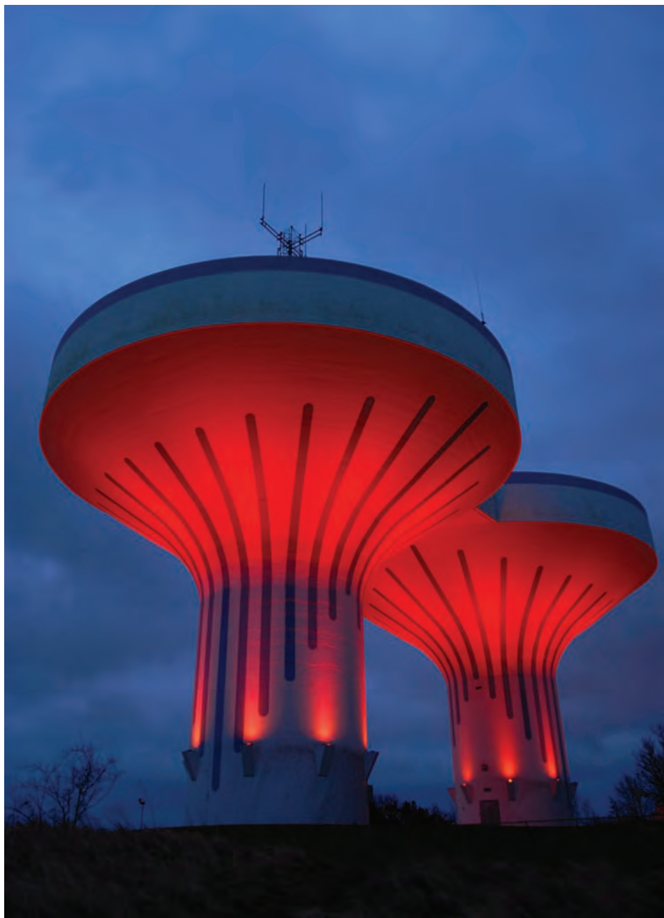
Ljussättning av vattentornen, ett samarbete mellan Ystads kommun och Ystad Energi
