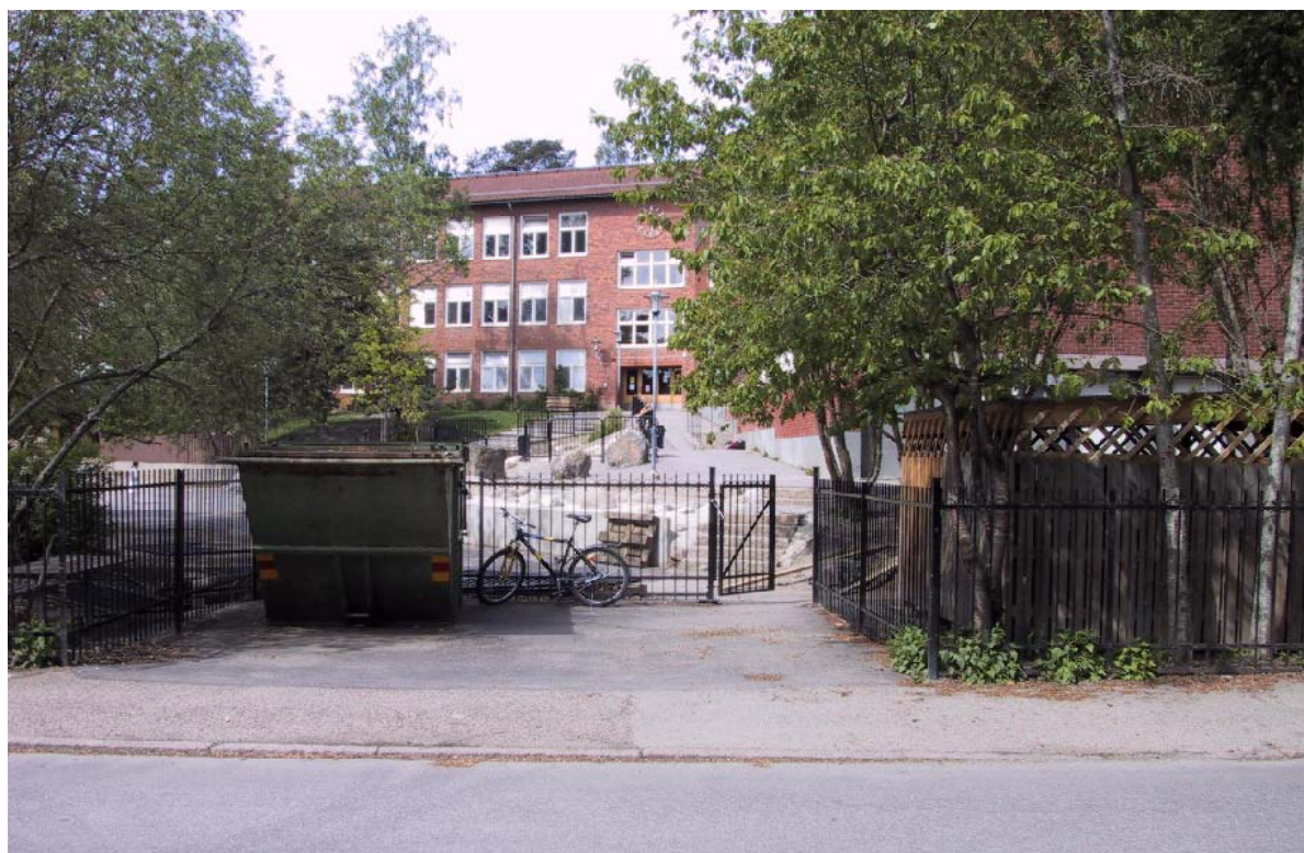
Björktorpsskolans entré mot Södra Brogatan där man möts av sopstation och container
