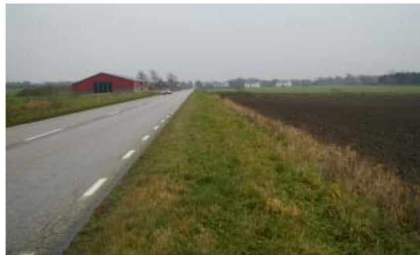
Bild 32. Väg 104 in mot Harlösa västerifrån. Cykelvägen planeras på södra (högra) sidan av vägen.
