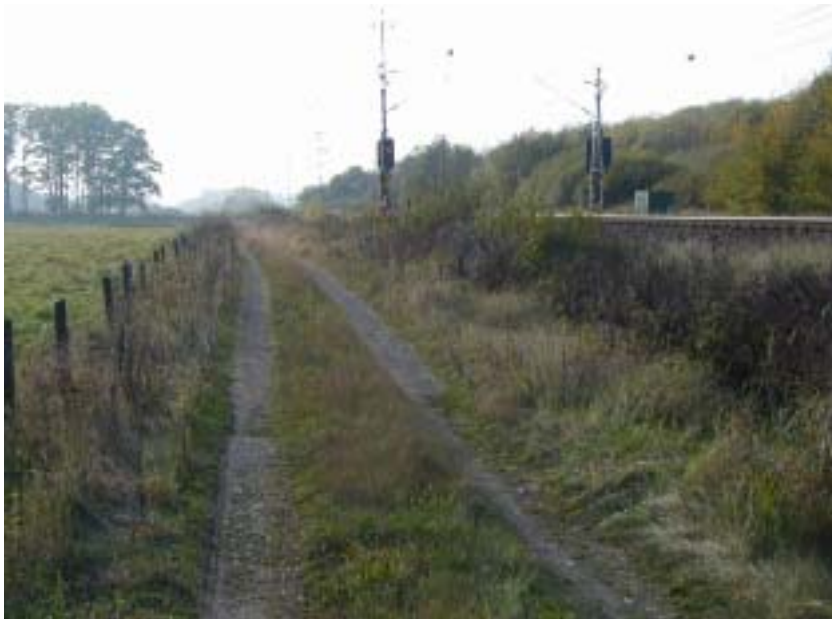
Bild 17. Grusväg med vegetationssträng mitt i vägen. Vegetationen längs kanten börjar bli hög och växa in över vägen.
