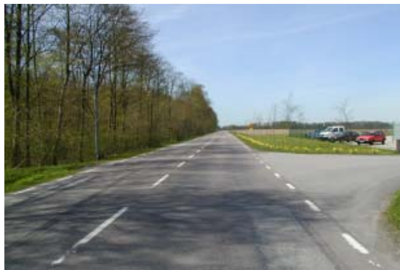
Bild 41. Väg 1119 västerut från Löberöd. Ny cykelväg läggs på norra (högra) sidan av vägen.
