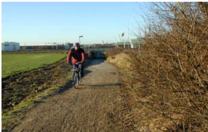
Bild 1. Cykelvägen under väg 113. Fotot är taget in mot Eslöv.
