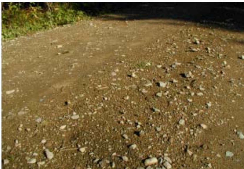
Bild 4. Materialet på skogsvägen norr om väg 17 som gör att det blir en väldigt hoppig och skumpig cykeltur.
