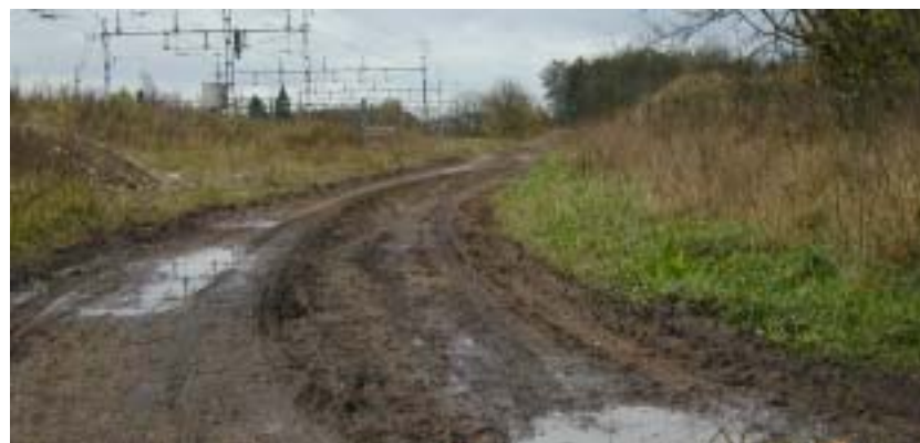
Bild 25. Traktorvägen upp till järnvägsstationen i Örtofta är i dåligt skick och behöver förbättras.
