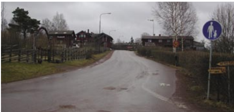
Tällbergsvägen (väg 920) söderut från korsningen med Siljansvägen (väg 927).
