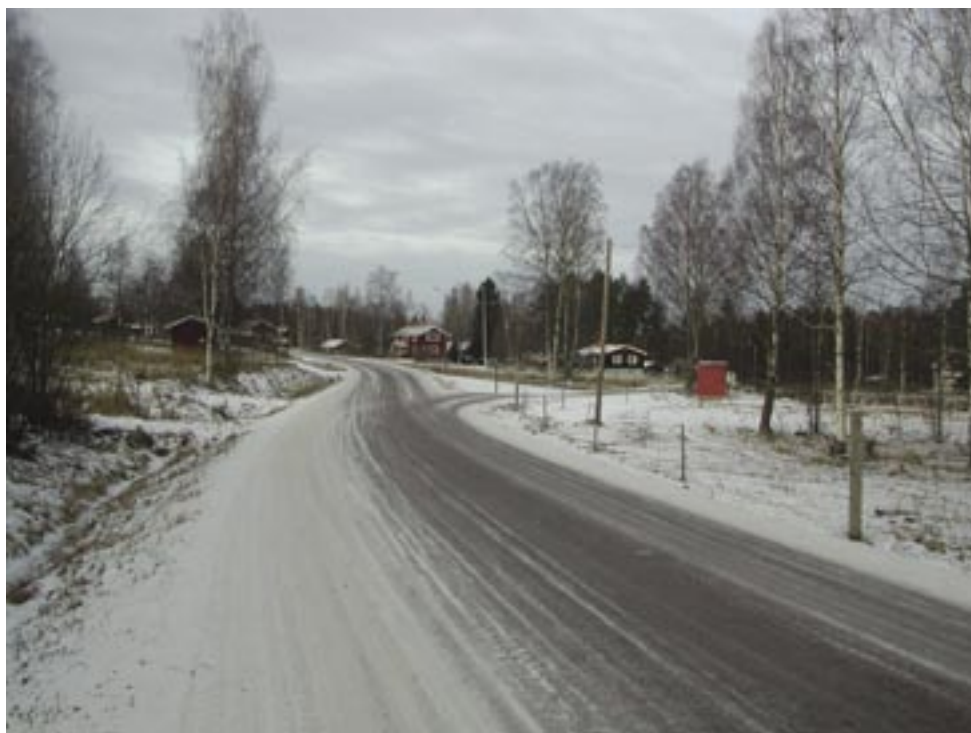
Väg 927 Siljansvägen. Bilden visar den sneda korsningen med Jönsgattu.
