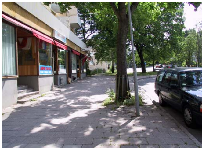
Foto: Gångbana runt Tidaholmsplan visar otillgängliga entréer.
