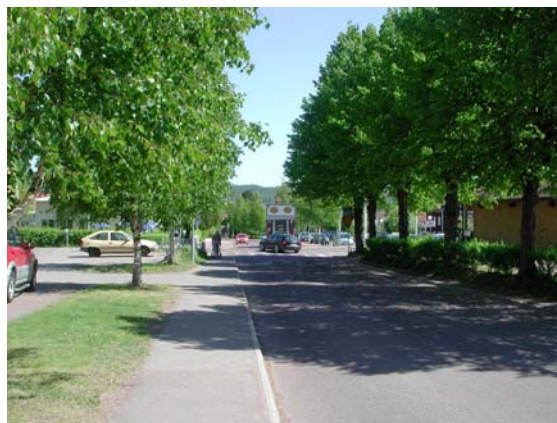
Sveagatan mot öster, strax före korsningen med Leksandsvägen; hållplatsläge för avstigande
