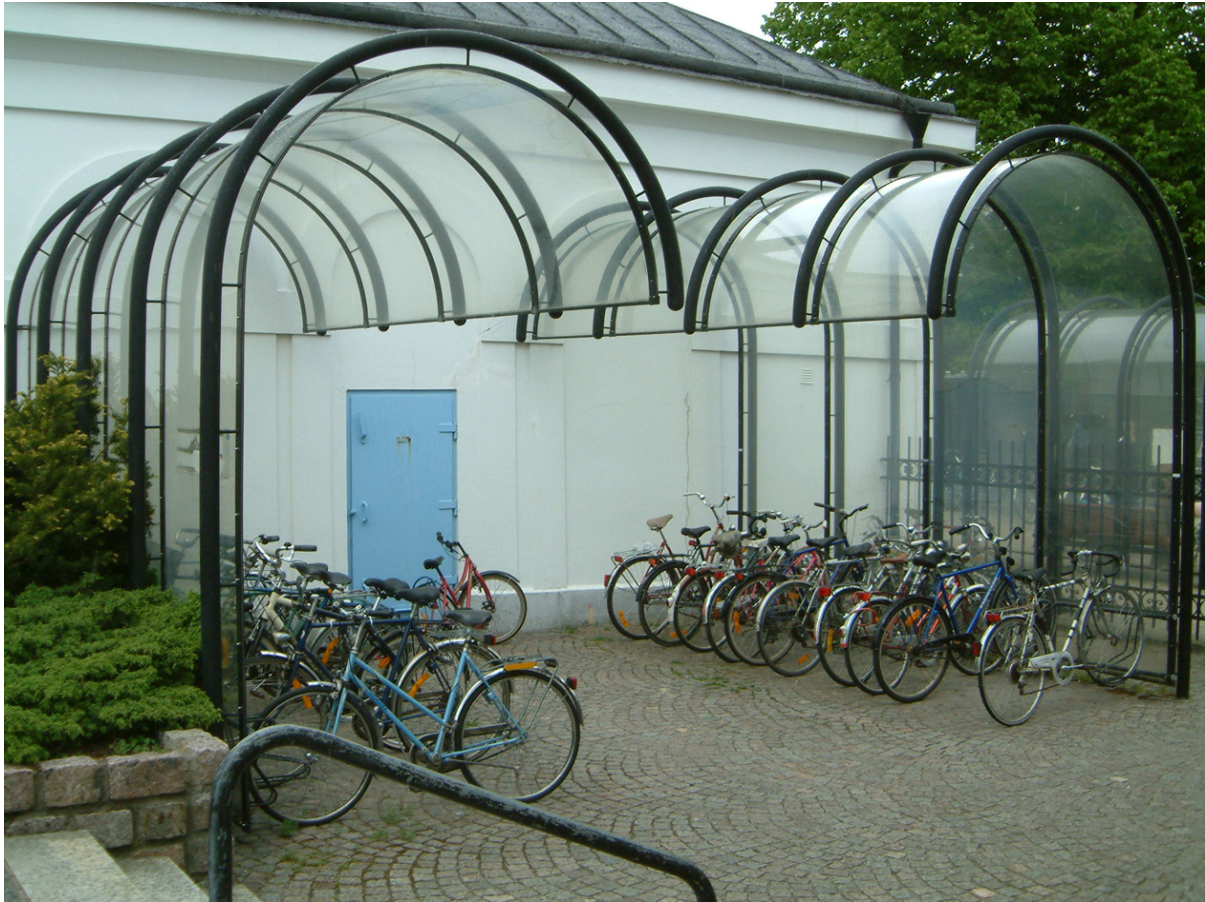
Bra cykelparkering vid Karlskrona C som lätt kan ges belysning och möjlighet till ramlåsning
