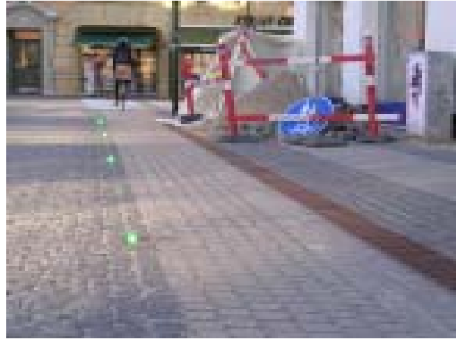
Gröna ledljus i cykelspår, Fredriksberg, Danmark. Foto: Tekniska förvaltningen.
