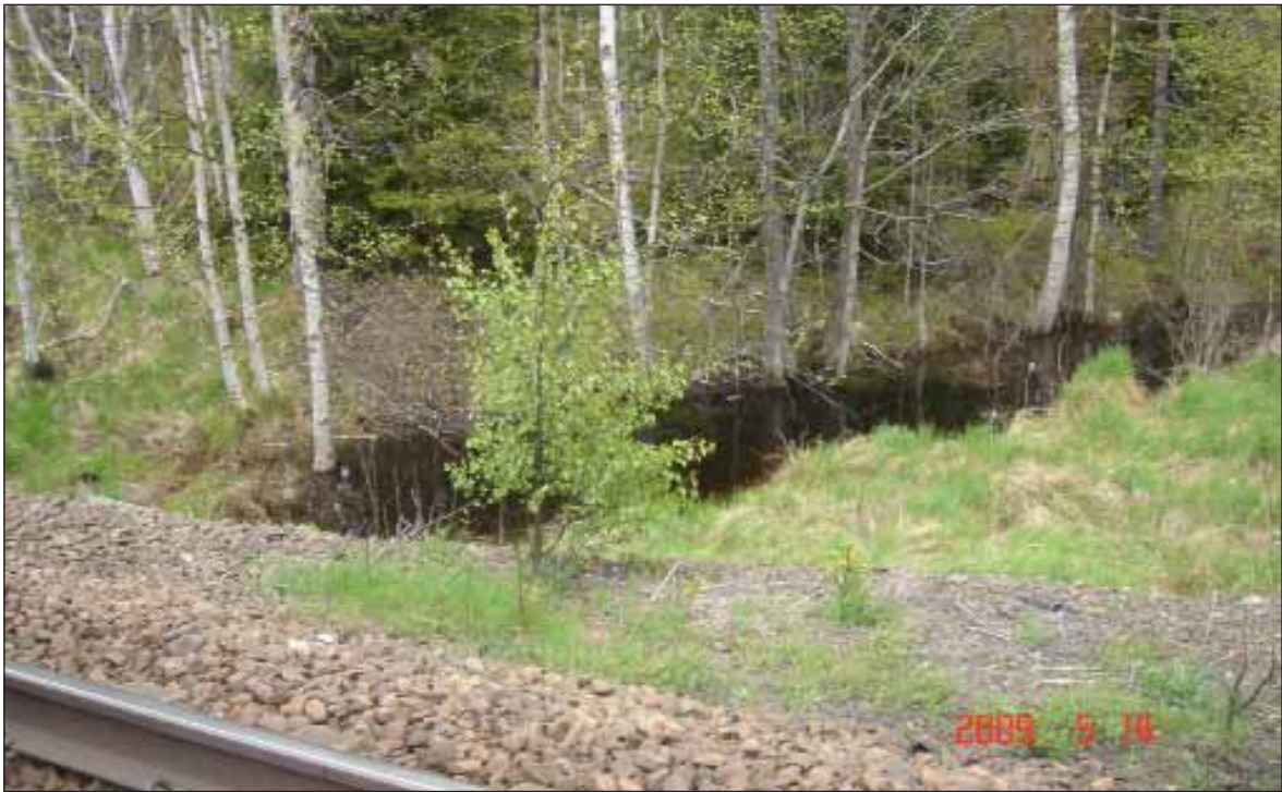
Figur 22. Bilden visar Bankällan där Stenbäcken går i trumma under banvallen vid km 234+600.
