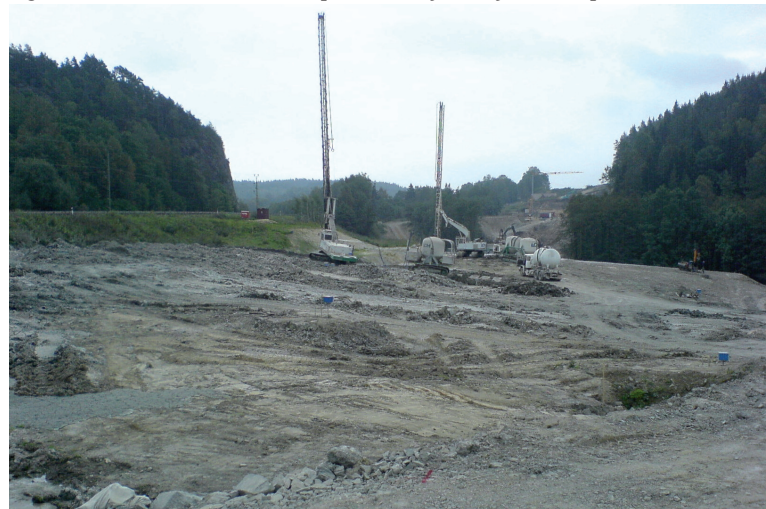
Figur 2.3.4:2 Installation av KC-pelare medför omfattande påverkan.
