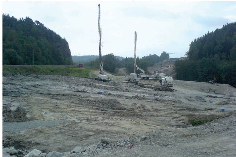
Figur 2.3.4:2 Installation av KC-pelare medför omfattande påverkan.
