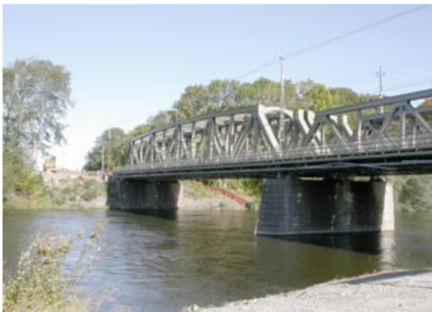
Fackverksbron från 1919-21 bär Östra stambanan över Motala ström och är av stort teknikhistoriskt intresse. Foto ALag.
