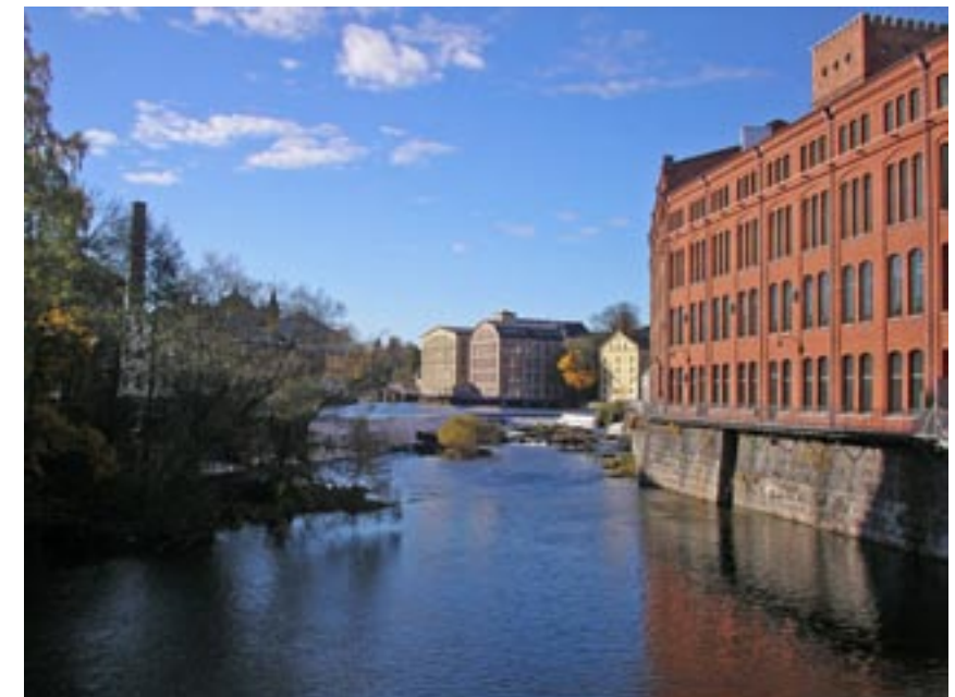
De gamla fabriksbyggnaderna kring Motala ström är idag både en turistattraktion och en viktig källa till kunskap om Norrköpings ursprung och karaktär som industriort. Foto AHJ.
