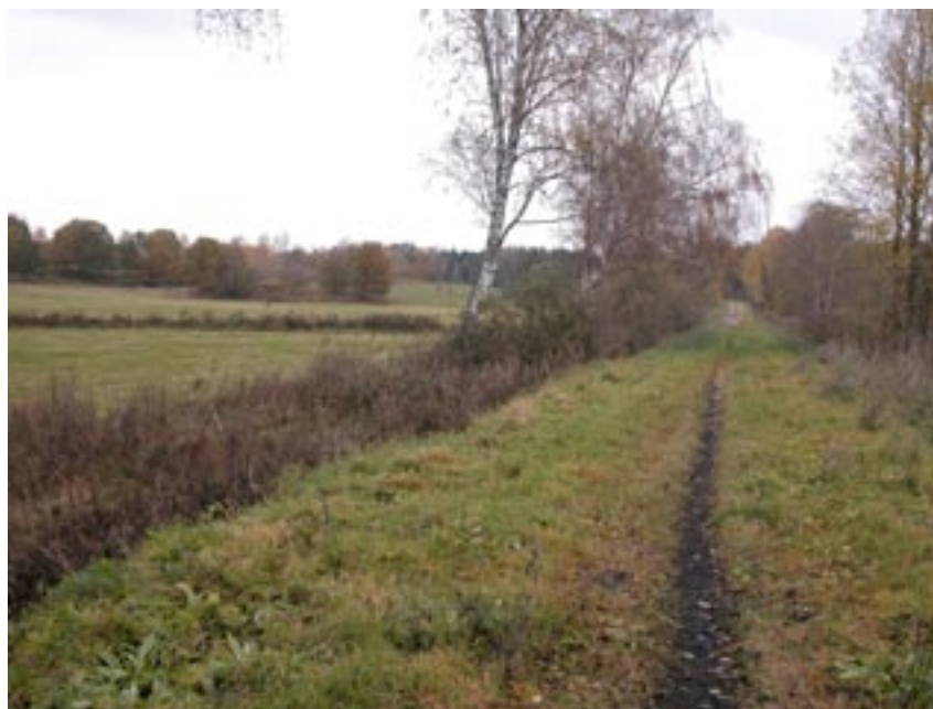
Den gamla järnvägsbanken över Resebromosse är en rest av den smalspåriga järnväg som gick mellan skogs- och bergsbrukstrakterna vid Finspång och hamnen i Norrköping. I närheten finns den f d station som anlades intill Lövestad. Godsets påverkan på landskapet var stor ännu under industrialiseringsfasen. Foto AHJ.
