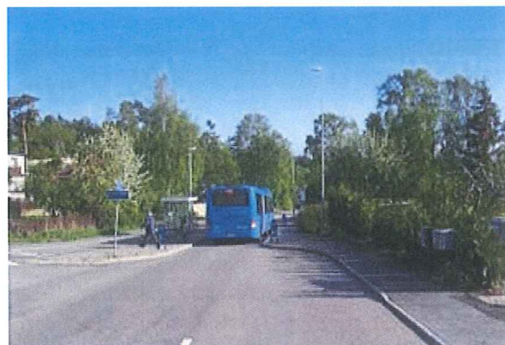
Timglashållplats - båda riktningarna blockerade.
