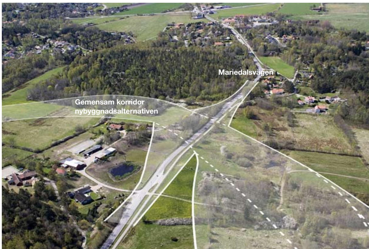
Vy mot väster vid Mariedalsvägen som kommer att anslutas till den nya vägen med en cirkulationsplats ungefär i bildens mitt.
