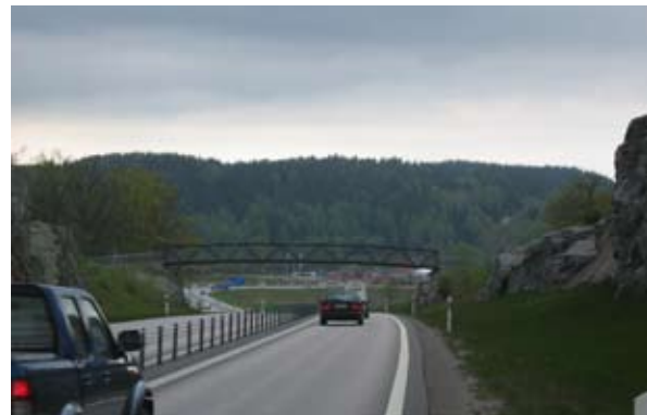
Bro över väg med mittseparering.
