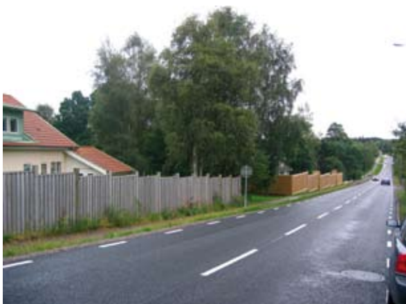
Alternativ Förbättrad Befintlig Väg kommer att få ett likartad utseende som den redan genomförda ombyggnaden i Forsbäck.
