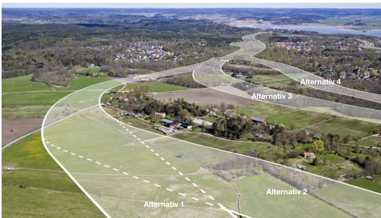
Vy mot norr och grusåsen vid Norrelund. Alternativ 1 och 2 ligger väster om åsen medan Alternativ 3 och 4 ligger öster därom.
