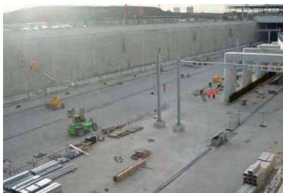
Figur 3.7: Exempel på permanent slitsmur. Utbyggnad av järnvägsförbindelsen London-Paris vid Stratford utanför London (foto: Peter Lidemar, Reinertsen Sverige AB).
