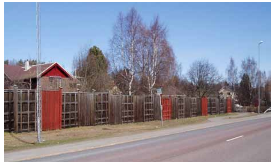
Exempel på bullerskärm från Järnvägsgatan i nära anslutning till Östra leden. Här med en träskärm som ytbehandlats med färg som anknyter till byggnadstraditionen.
