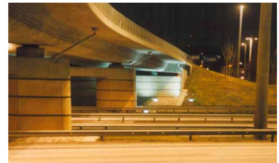
Exempel på effektbelysning av bro.
