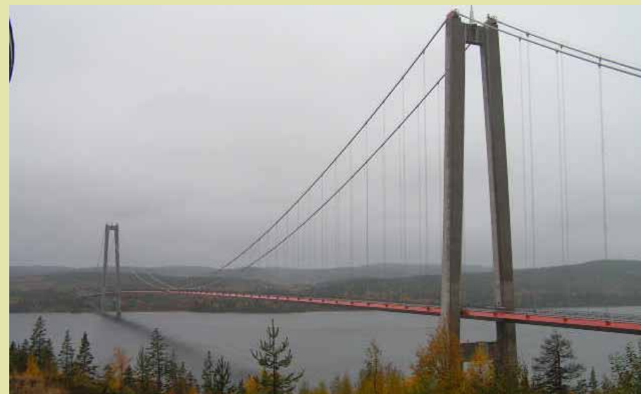
Högakustenbron där E4 passerar Ångermanälvens mynning.
