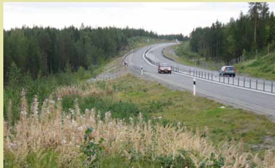
E4 söder om Skellefteå som är ombyggd till mötesfri landsväg med mitträcke, så kallad 2+1 väg.
