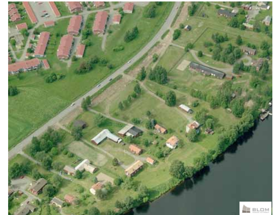
Delar av Södra Hedensbyn med skyddsvärd bebyggelse.
