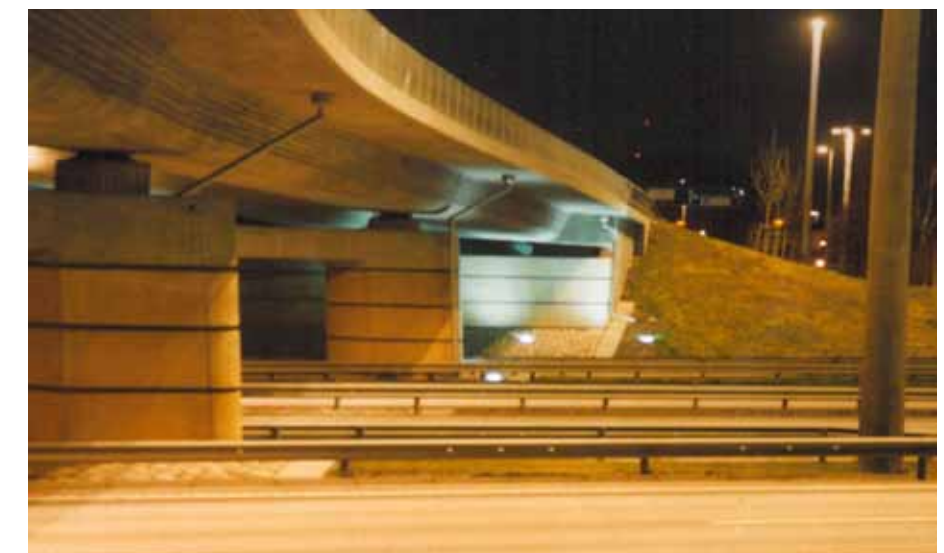
Exempel på effektbelysning av bro.
