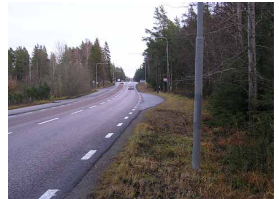
Figur 4.1.2 Väg 76 i Furuvik, vägsträckan berörs av järnvägsprojektet.
