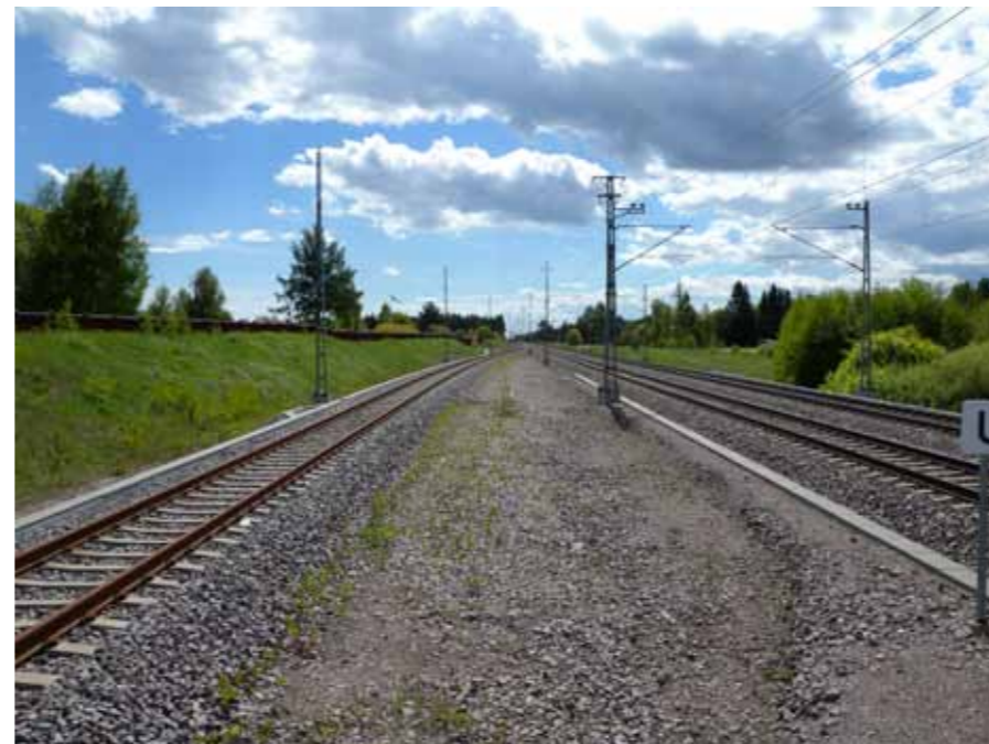
Figur 4.1.1 Befintlig järnväg vid Turkiet.
