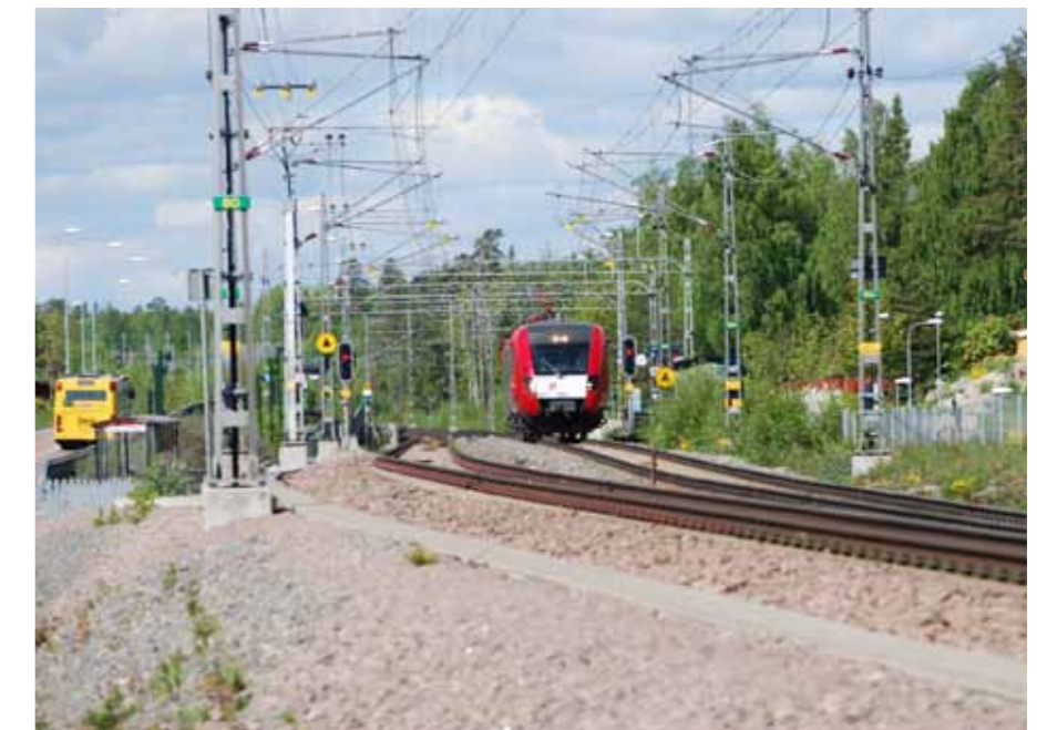
Figur 2.5.1 Befintlig järnväg i Furuvik.
