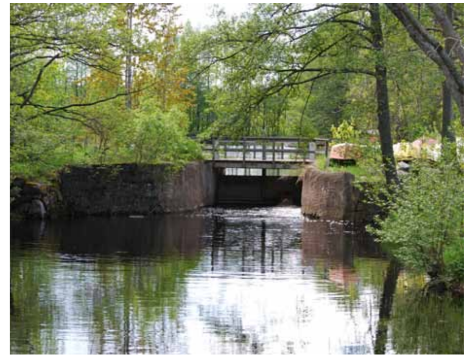
Figur 5.10.3 Damm vid Tröskens utlopp.
