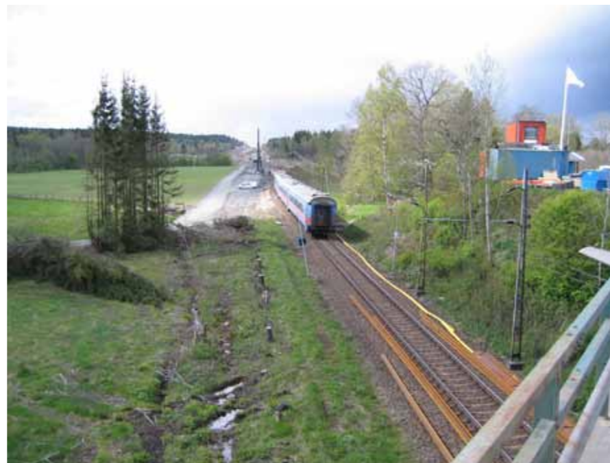
Figur 5.13.1 Exempel från Ostkustbanan under byggskedet.
