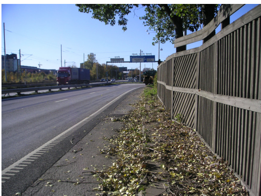
Bullerskärm mellan Lundbyleden och Brämaregården. Vy i västlig riktning.
