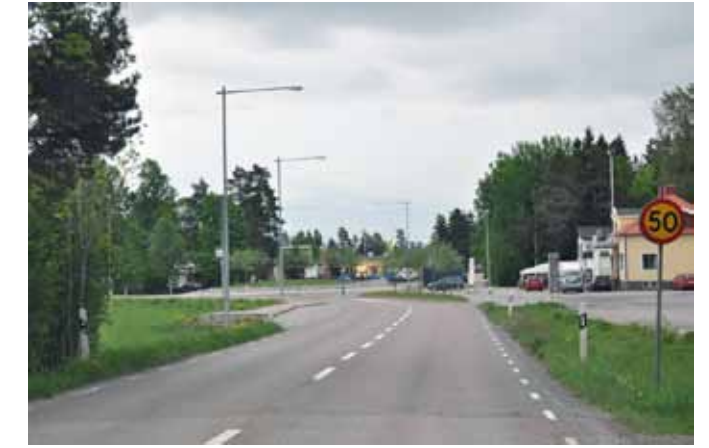
Figur 19. Väg 76 och infarten till Östhammar, vy mot söder.
