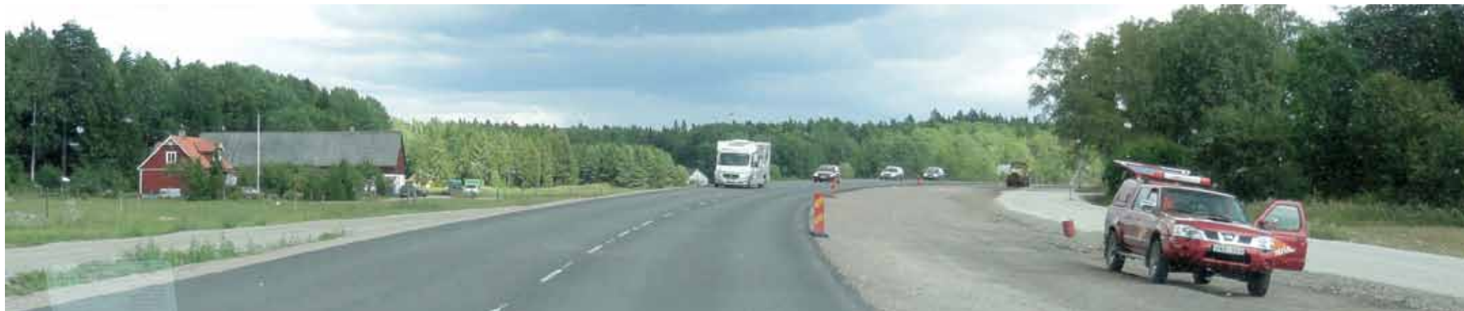
Figur 90. Ombyggnad av befintlig väg medför ofta ett extra komplicerat byggskede pga passerande fordonstrafik.
