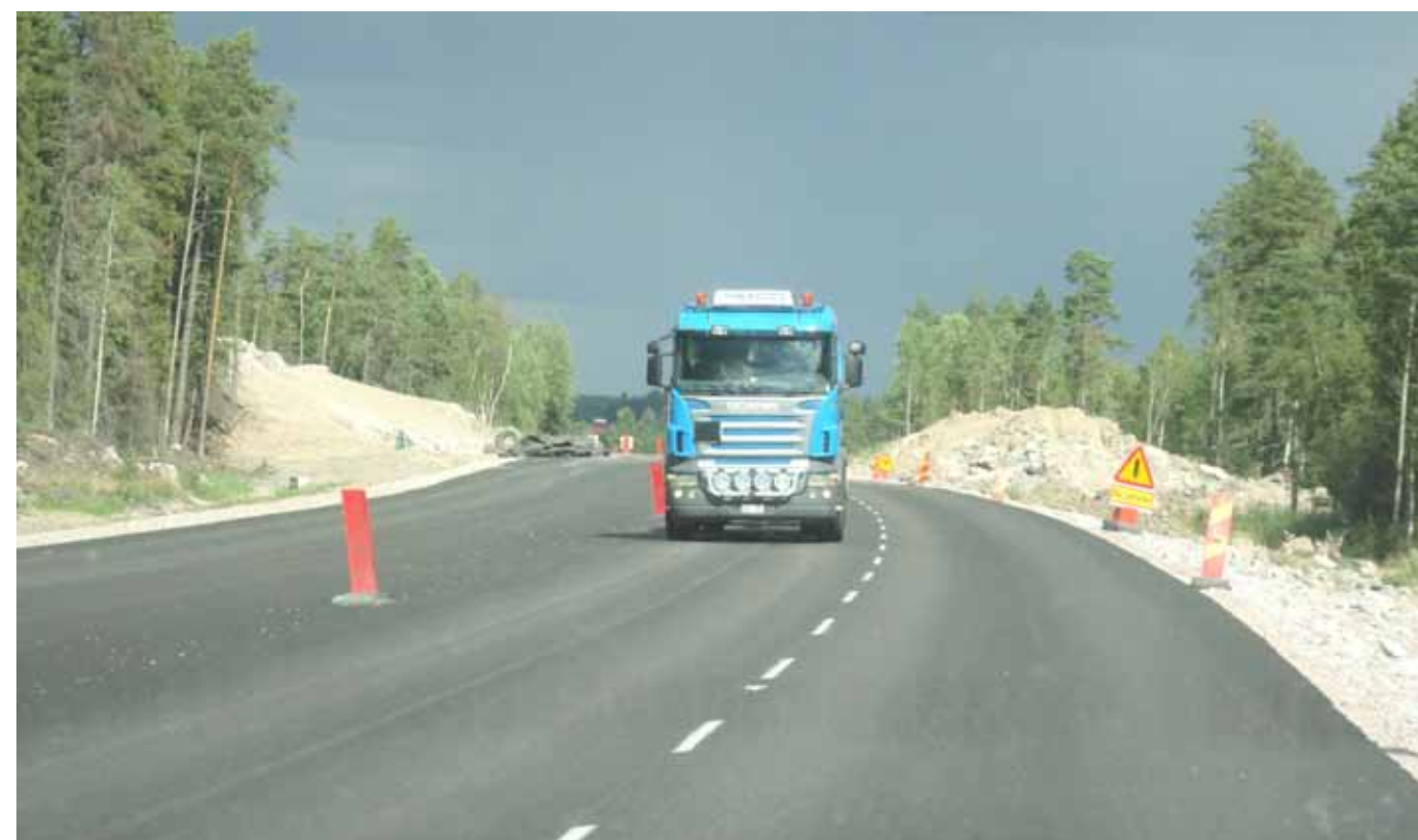
Figur 93. Ombyggnad av väg 288 på sträckan Jälla-Hov, exempel på blandtrafik.
