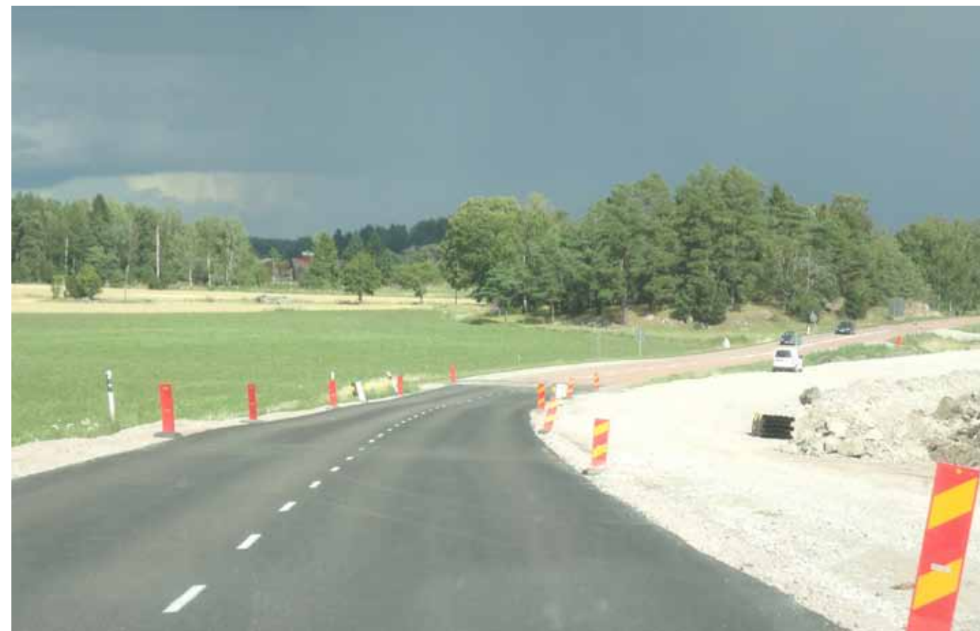
Figur 92. Ombyggnad av väg 288 på sträckan Jälla-Hov, exempel på markanspråk för mötesfri väg.
