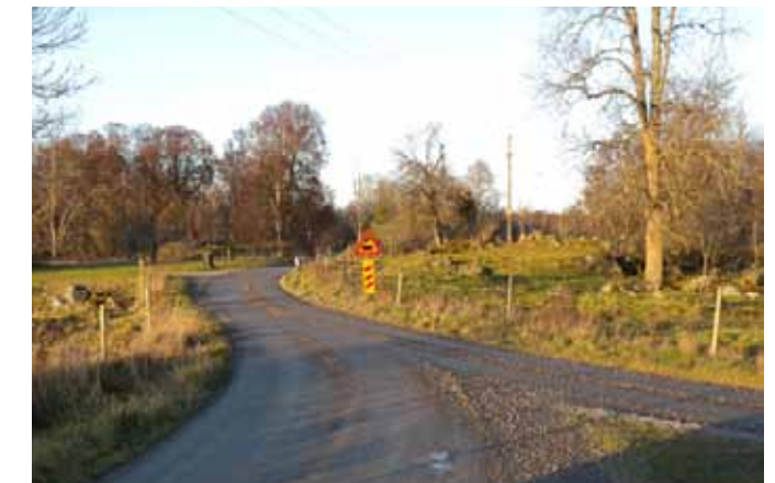
Figur 91. Passage av järnväg medför särskilda risker under byggtiden.
