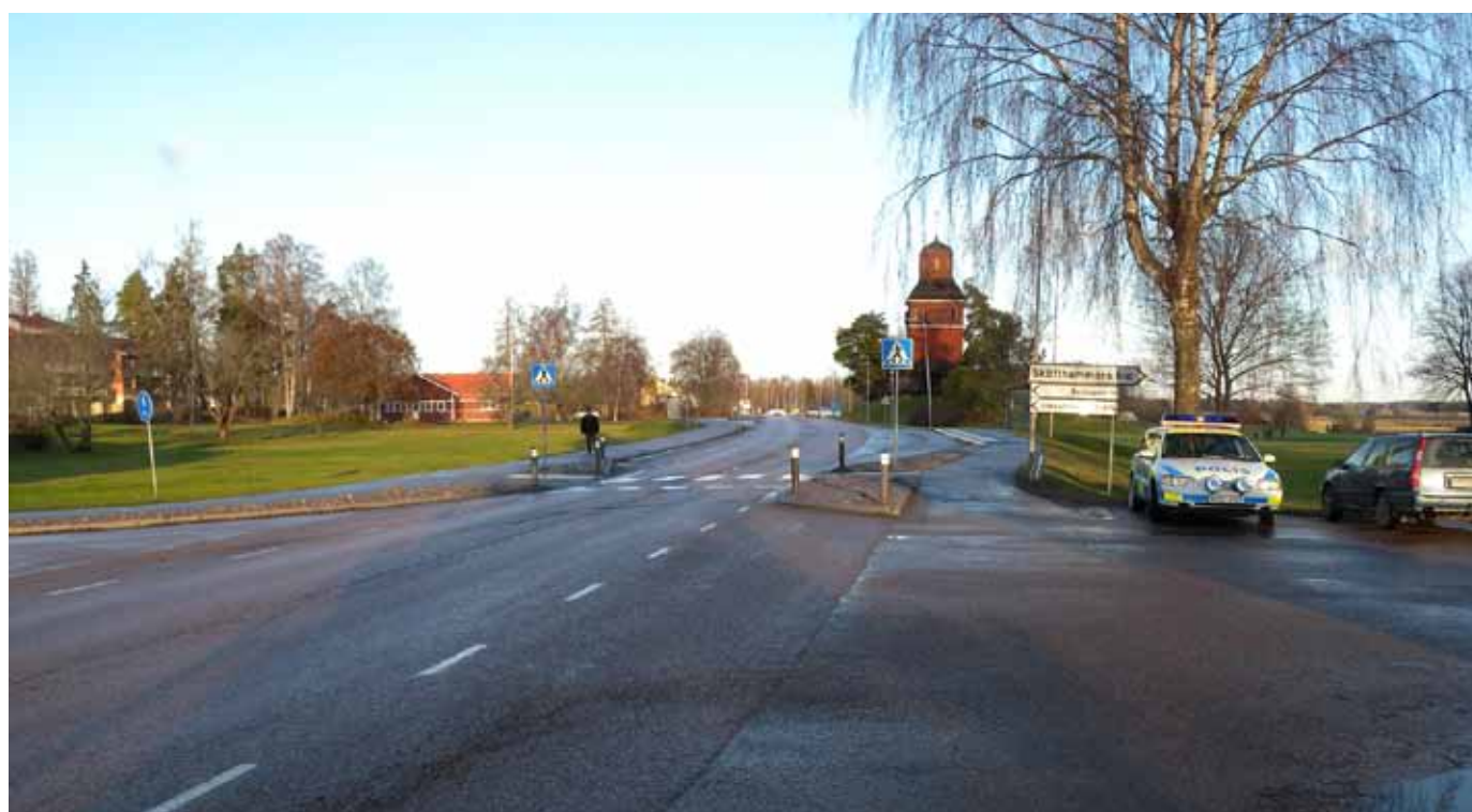
Figur 29. I Gimo finns behov av att både passera längs och tvärs väg 288.
