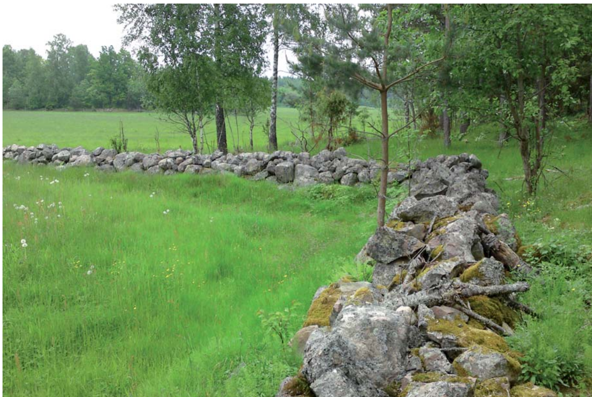
Figur 5.3 Stenmur vid Kulla (km 2/550)
