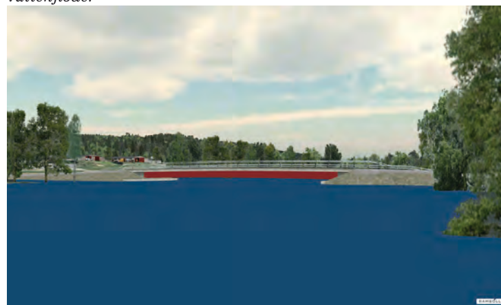
6.3:6 Gång- och cykelbron sedd från sydost vid högsta högvattenvattenflöde.
