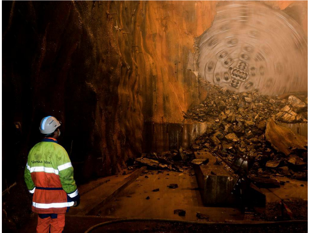
Figur 7 Genombrott i det östra tunnelröret.
