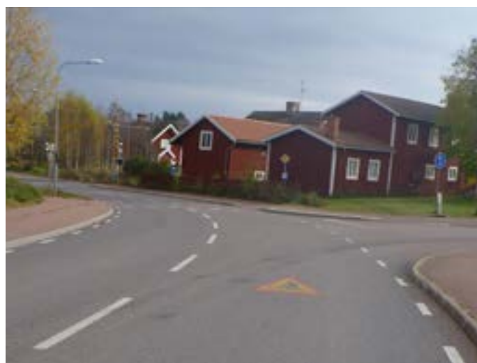
På Stationsgatan är varning för cyklister målat i gatan, men hastigheterna är ändå för höga och trafiksäkerheten för cyklister är låg vid passagen över gatan.
