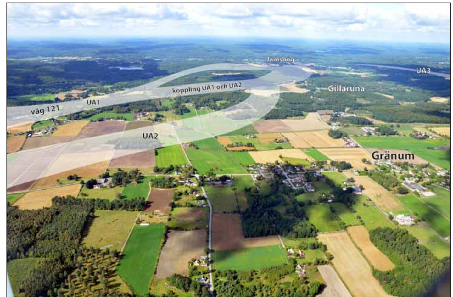
Figur 6.23 Flygbild tagen österifrån mot Grännum och västerut mot Jämshög, se figur 6.22 för pil i fotoriktning. UA 2 korsar tvärs över Gränumsdalen.
