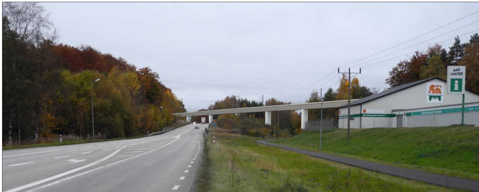
Figur 6.14 Foto som visar passagen över väg 121, kraftledningsgatan och Holjeån.
