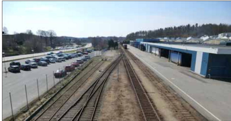
Figur 7.26 Järnvägen, väg 121 och parkeringar delar Olofström i två delar; bostäder och centrum till vänster, industri till höger. Vy mot söder.
