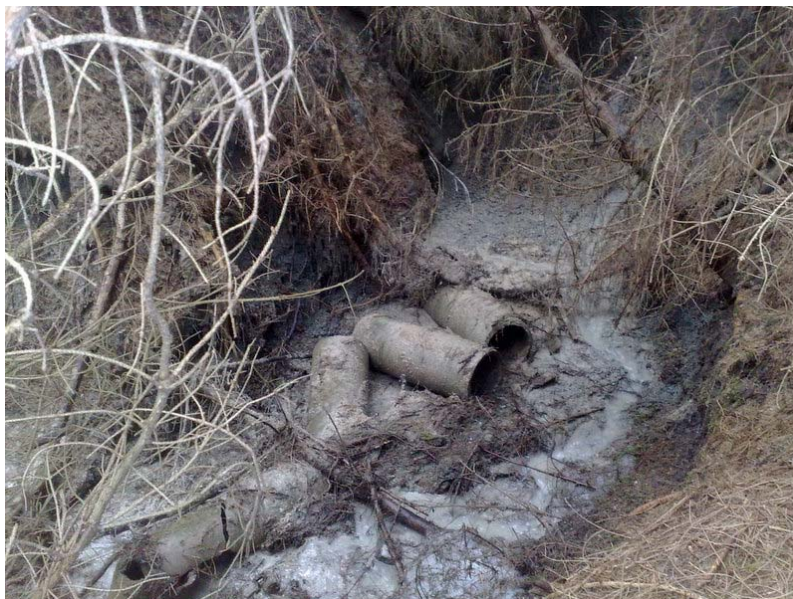
Figur 7 Raserad ledning på grund av skred, nedströms 6+350
