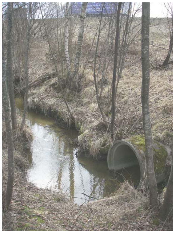
Figur 4 Vägtrumma där Pulsebäcken passerar under nuvarande väg E6
