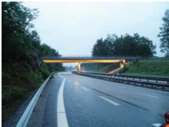
5.2:5 Bron i trafikplats Västra Bodarna
