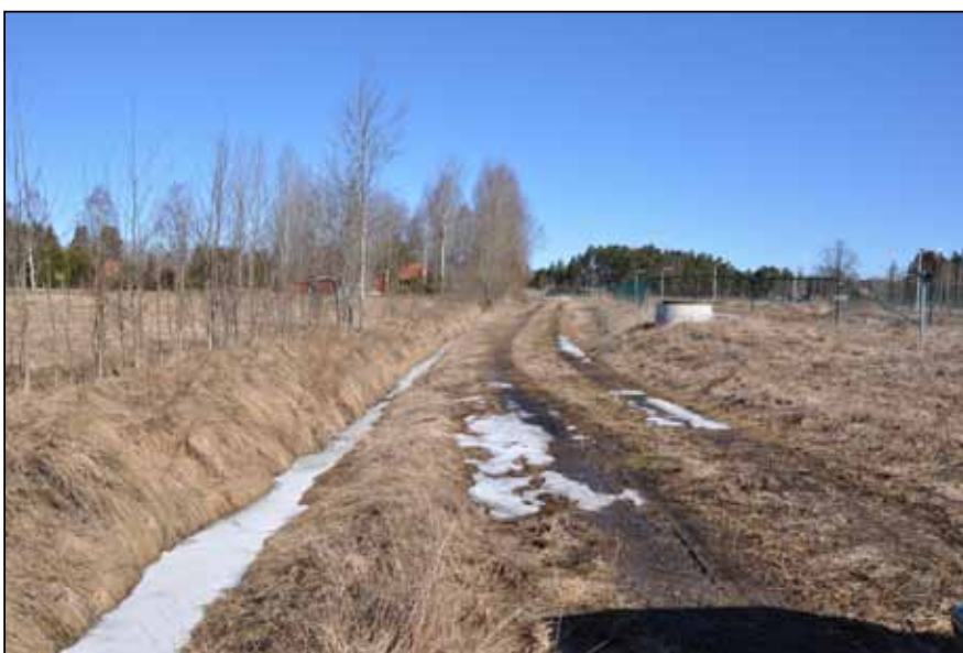
Figur 4.8 Dike 6 i figur 4.3. Inhägnaden av dagvattendammen söder om Pappenhagens väg syns till höger i bilden.
