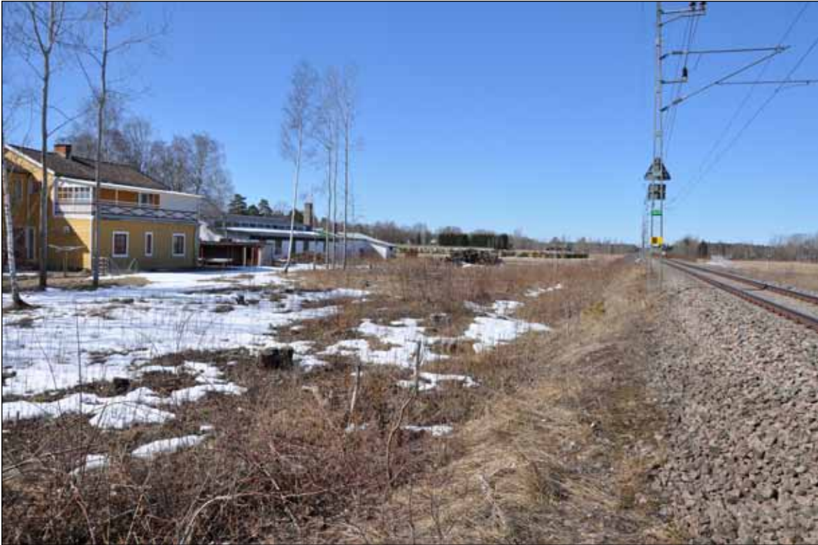
Figur 4.12 Läge för bullervall öster om planskildheten för biltrafik. Bilden är tagen i riktning mot Kalmar. Vallen kommer att ligga söder om järnvägen, till vänster i bilden.
