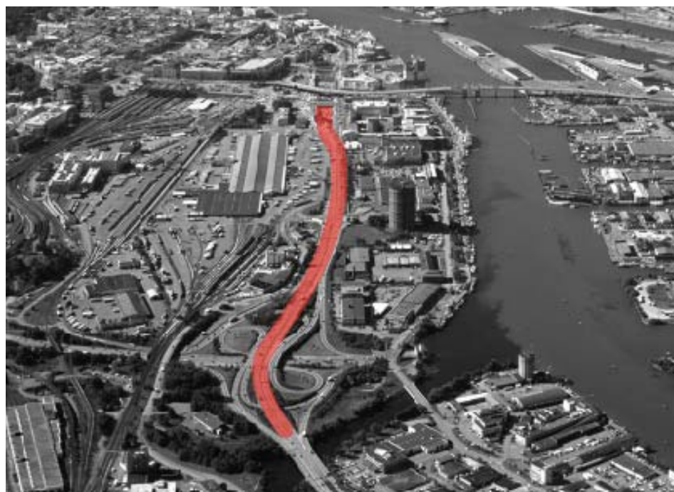
Figur 2.6. Flygbild över centrala Göteborg, vy österifrån, med aktuell del av E45 markerad i rött.
