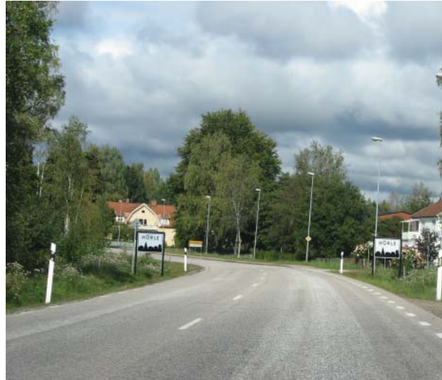
Väg 846 mellan Värnamo och Hörle, infarten till Hörle med befintlig gångväg på östra sidan.
