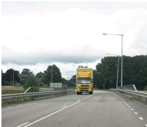
Bron där väg 558/559 korsar väg 27
