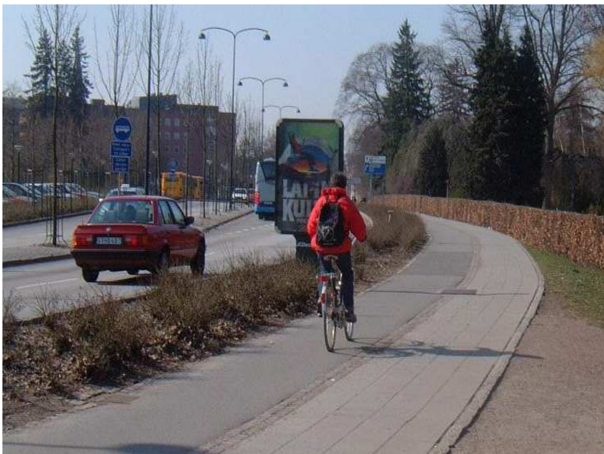
Bild 3.15 Separering med plattor och asfalt
