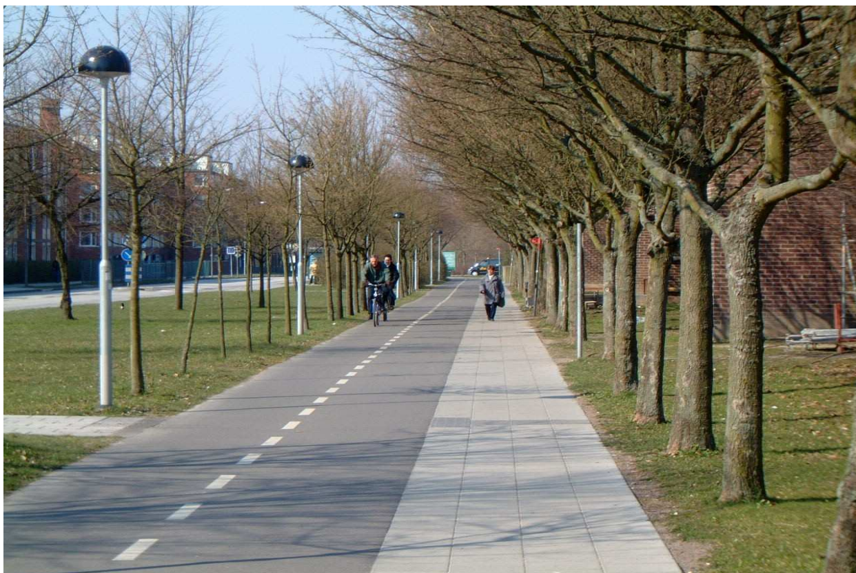
Bild 3.16 Separering med plattor och asfalt med mittlinje för cykelbanan
