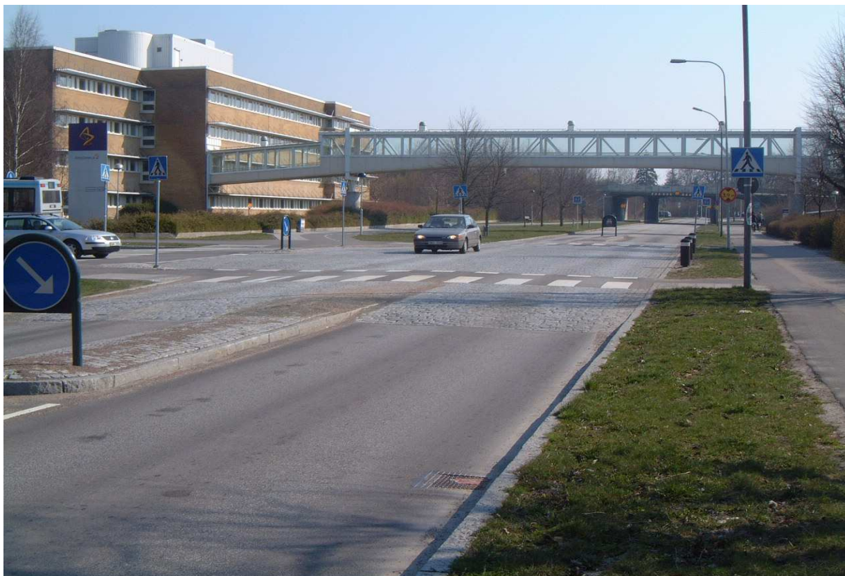
3.12 Plåtå som hastighetssäkrande åtgärd
