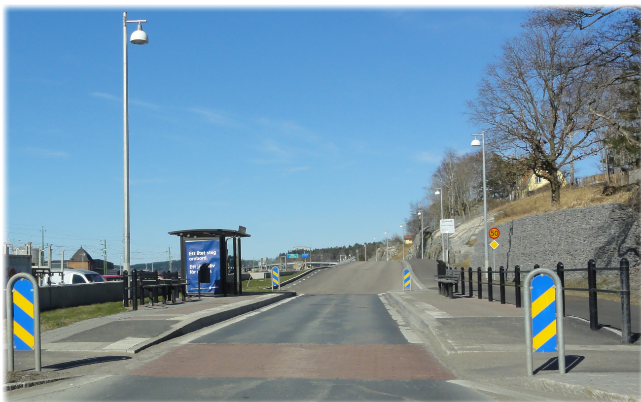
Figur 5. Timglashållplats Södra vägen på nya parallellvägen i Nol.
