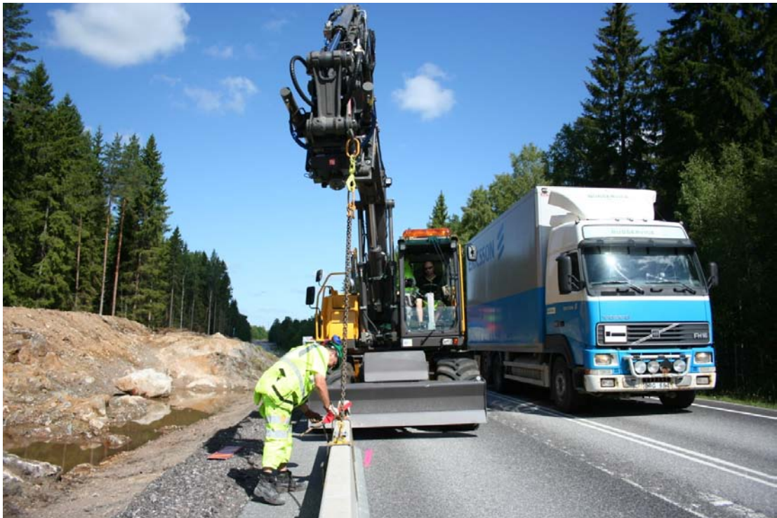
Montage av barriärelement vid breddning av del 1 2011-06-28
