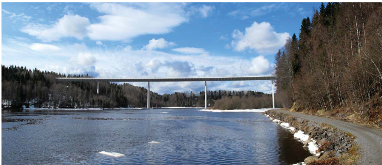
Figur 4. Utsnitt ur MKB för Väg E12, delen Röback - Klockarbäcken. Trafikverket, Tyréns. Fotomontage med utförande i 6 spann.
