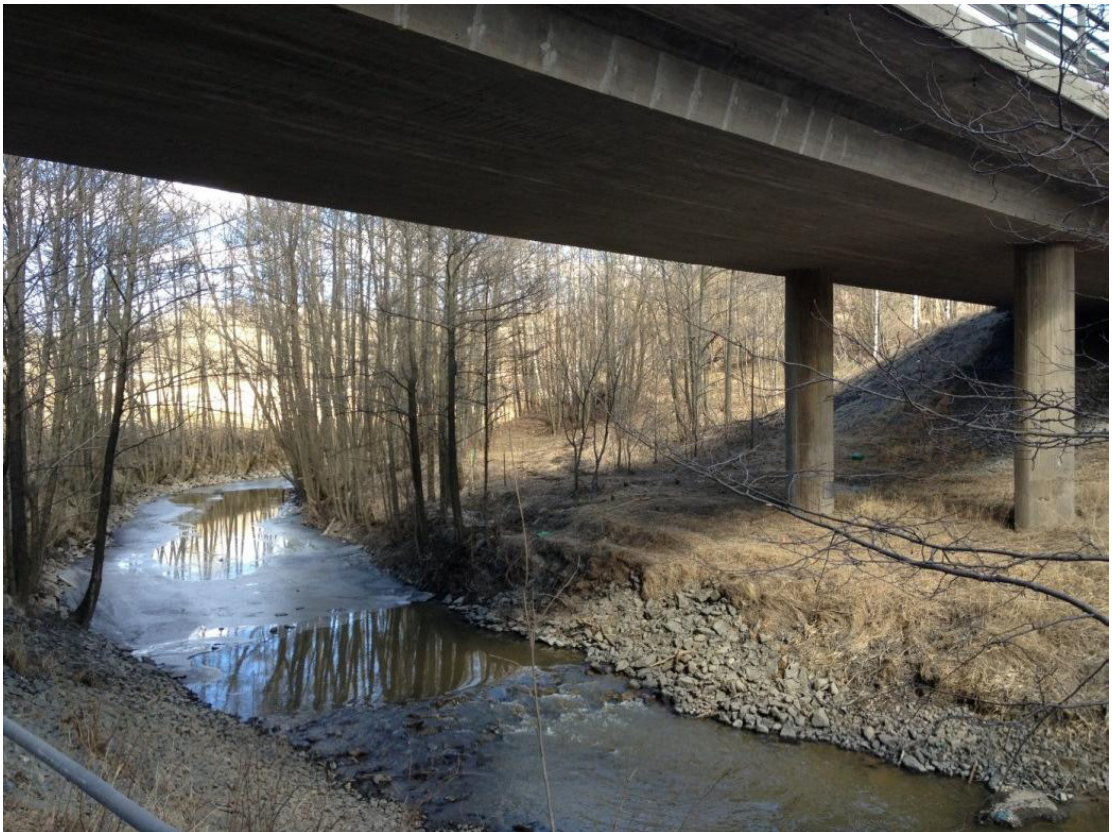
Figur 9 Befintliga erosionsskydd vid bron över Lärjeån. Den övre bilden visar den västra sidan med gång- och cykelväg parallellt med ån och den nedre bilden visar den östra sidan.
