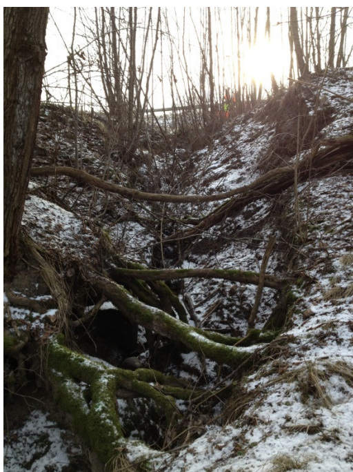
Foto 4. Befintligt dike på norra sidan av väg 190 vid sektion 11/340. Foto taget mot sydost.
