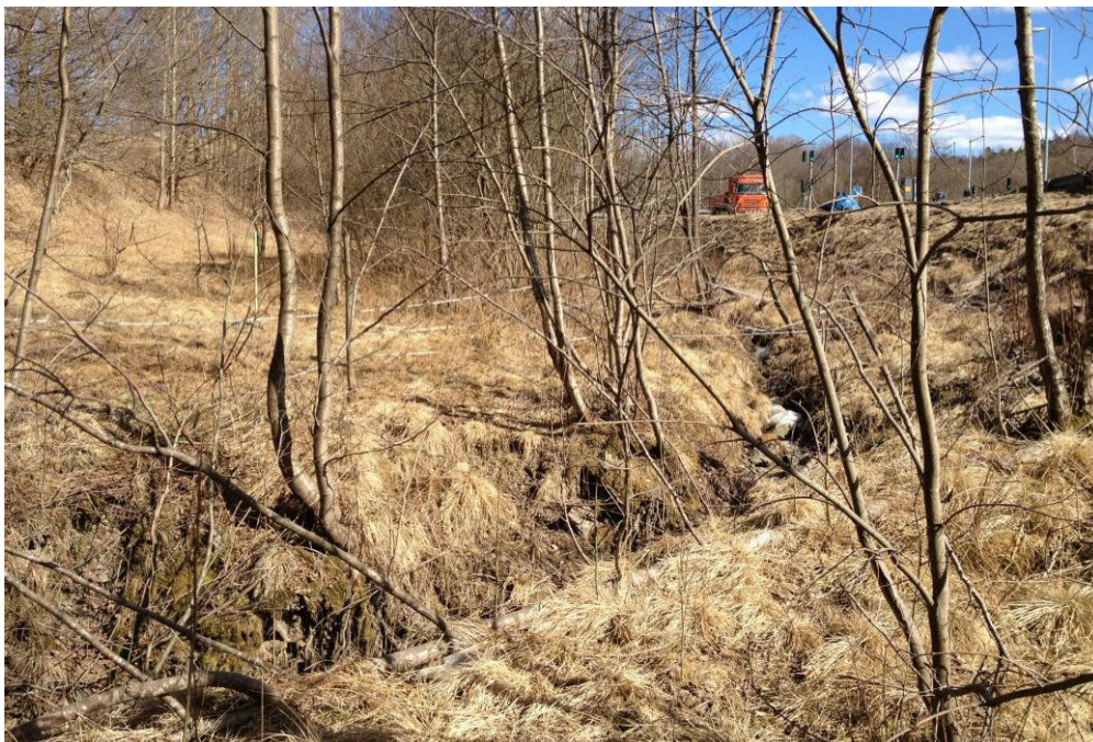
Figur 10 Befintligt dike på norra sidan av väg 190 vid sektion 11/340 där det viker av ner mot Lärjeån. Foto taget mot öst.
